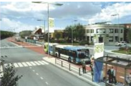
Le SRB Pie-IX comprendra deux voies bidirectionnelles au centre du boulevard, des îlots sécurisés pour l'embarquement et une vingtaine d'arrêts sur 10 km.
