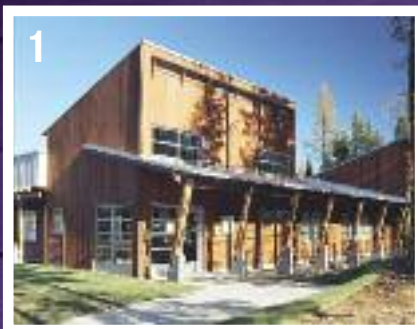
1 Poste de la Sûreté du Québec à Lac-Beauport : un bâtiment public construit en bois et répondant à des critères de sécurité élevés. Architectes : Lemay et associés, Québec, concepteur : Claude Guy. Ingénieurs en charpente et génie civil : SNC Lavalin. Année de la construction : 2005. Classe du bâtiment : D. Aire du bâtiment : 870 m 2
